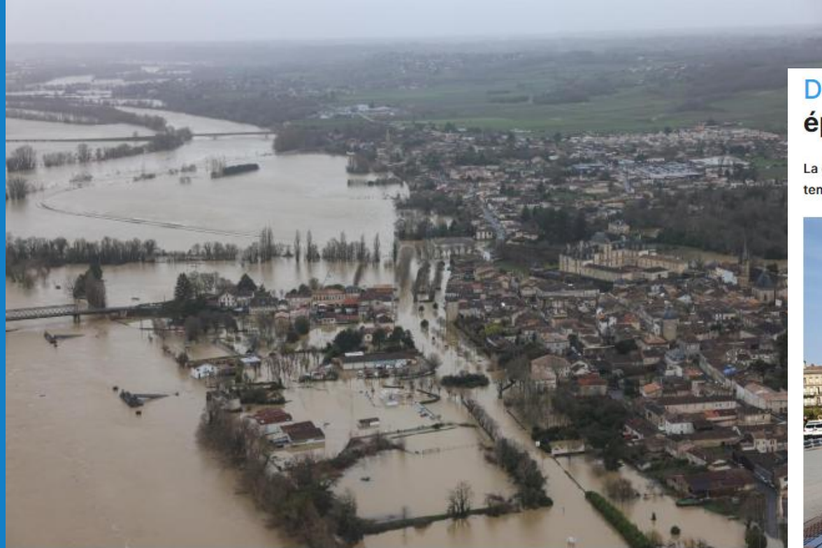
Les rives de Cadillac-sur-Garonne, en Gironde, (dont on aperçoit le château sur la droite) ont été nettement submergées par le fleuve. Claude Petit / SO
